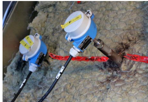
Temperatursensoren im Heizsystem
