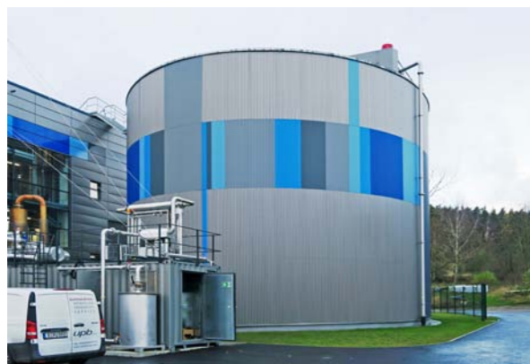
Faulbehälter mit einem Volumen von 3.000 m 3
