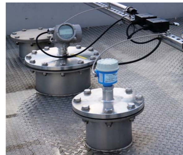
Füllstand-, Temperatur- und pH-Messung im Faulbehälter
