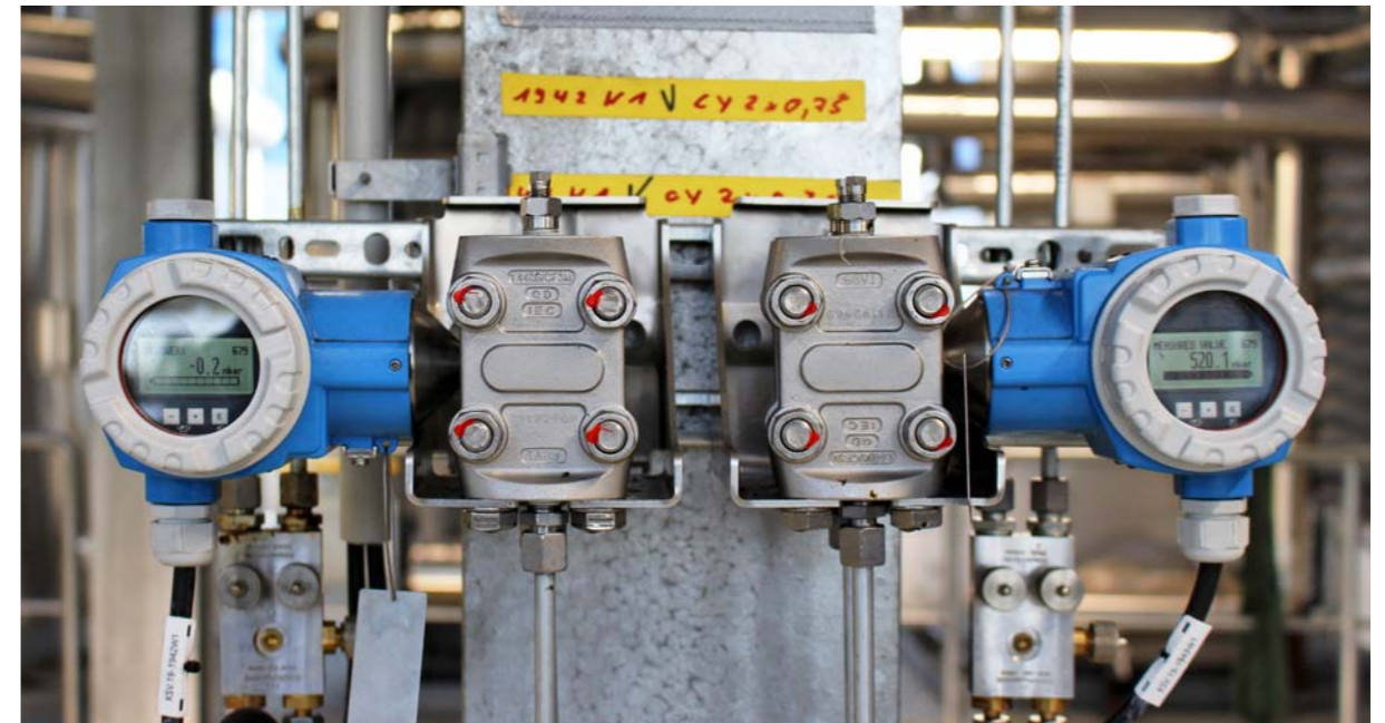
Durchflussmessung des Thermoöls vom Kessel (links) zum Trockner (rechts)
