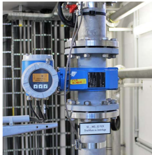
Magnetisch-induktive Durchflussmessung im ausgefällten Klärschlamm (Zulauf Zentrifuge)
