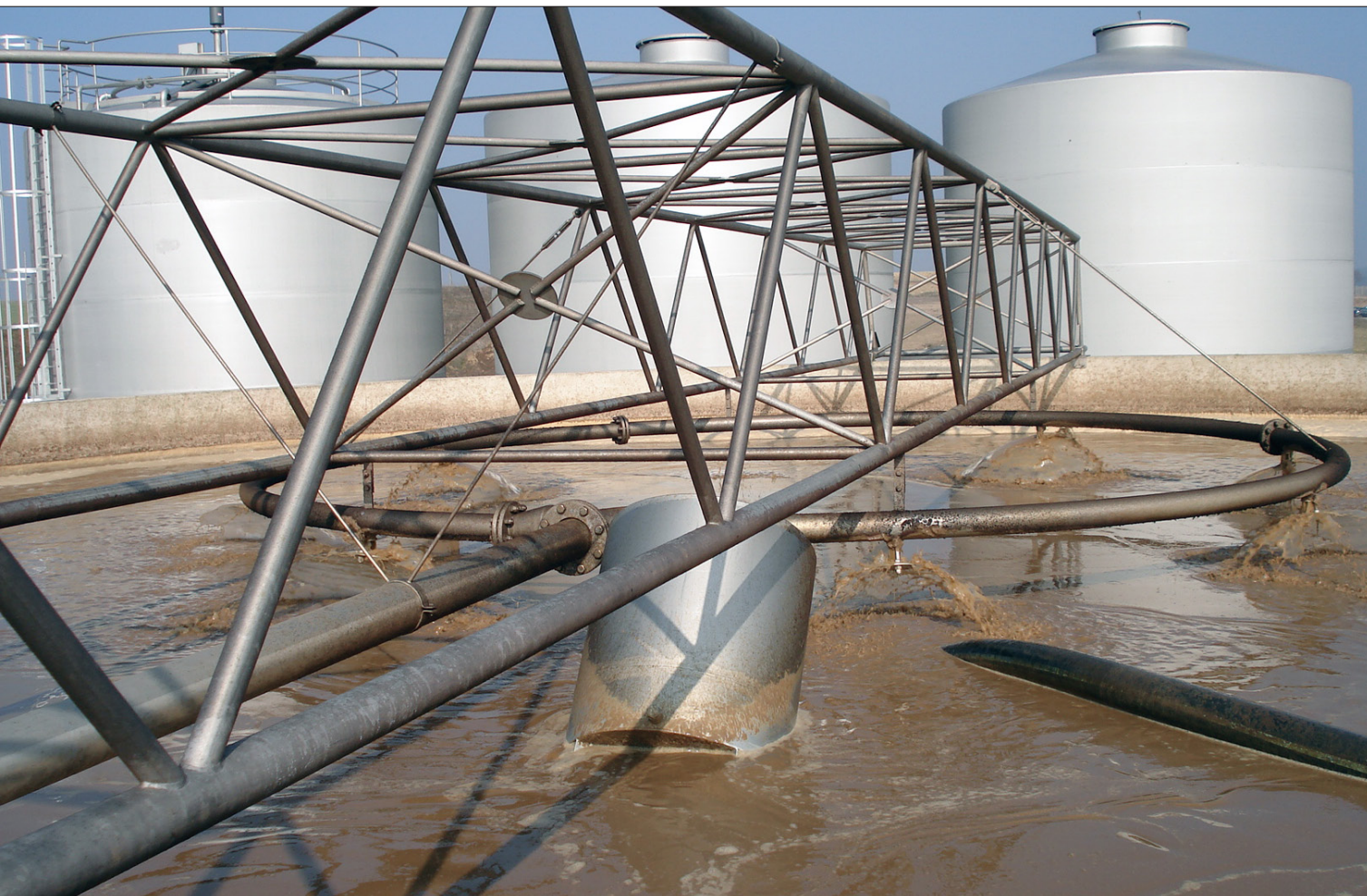
Aufbereitung von Lebensmittelabwasser mit dem Sequency Batch Reactor. Diese Technologie fasst zwei Reinigungsschritte zusammen.
