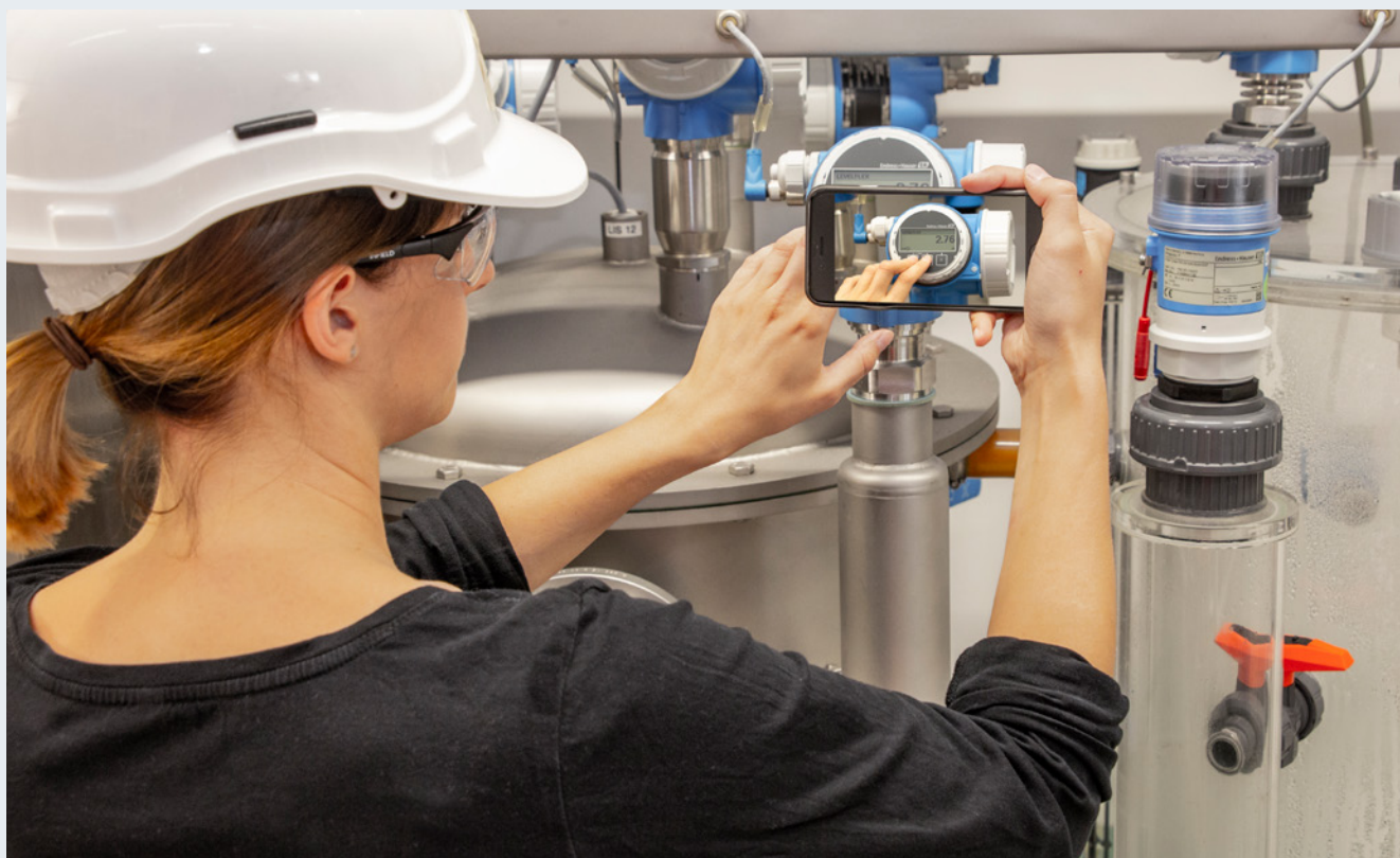
Anwendung visueller Service App am Messgerät in der Anlage.
