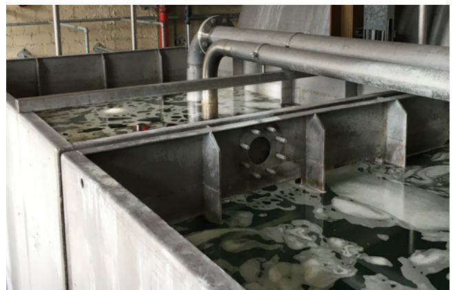
Das Brüdenwasser im Heiß- (links) und Kaltwasserbecken (rechts), jeweils vor und nach der Kühlung im Verdunstungskühler.
