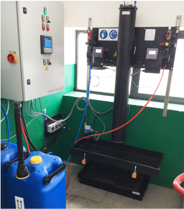
Voller Einsatz: Clorius2-Generator mit Schaltschrank und Eduktefäs- sern bei Hochwald in Ertstadt.
