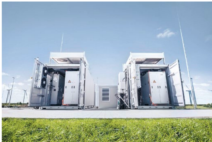
Die Elektrolyseure des Unternehmens H-Tec Systems sind kompakt gebaut: In mobilen Containern erzeugen PEM-Stacks effizient Wasserstoff.
